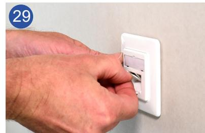
29 Nach Öffnen der Staubschutzklappen können Sie MegaLine Connect45 Pro SMART Anschlussdose in Betrieb nehmen.
