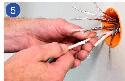
Schieben Sie den Schutzschlauch über die Aderpaare. An der Perforierung kann der Schutzschlauch bequem abgetrennt werden.
