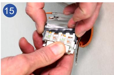
15 Zum Anschluss der Adern an den Anschlussblock entfernen Sie zunächst nur die untere Sicherungsklammer. Führen Sie bei TIA-568 B Codierung nacheinander zuerst alle braunen und orangen Adernpaare in die farblich codierten Anschlussklemmen bis zum Anschlag ein.
