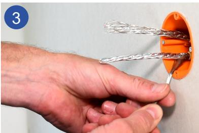
Öffnen Sie das Schirmgeflecht und wickeln es mit optionalem Beidraht so zusammen, dass keine Einzeldrähte lose in der Leerdose verbleiben können.
