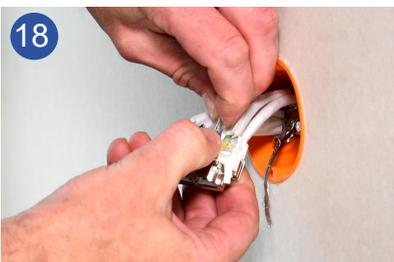
18 Führen Sie danach alle blauen und grünen Adernpaare in die farblich codierten Anschlussklemmen bis zum Anschlag ein. Achten Sie auch hier wieder auf die korrekte Farbzuzuordnung der Adern und die entsprechende Zuordnung zum jeweiligen Kabel.
