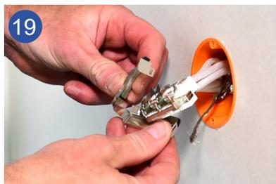
19 Legen Sie das Schirmblech mit der Schaumstoffdichtung nach hinten und mit der mittig ausgestanzten Kontaktfahne nach oben um das Anschlussmodul werden.
