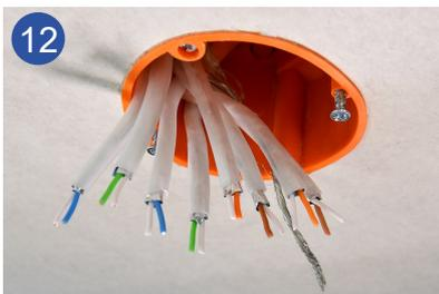
12 Achten Sie auf die gewünschte Codierung gemäß TIA-568 A oder B und sortieren die Adernpaare nach den zugeordneten Farben vor.
