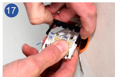
17 Drehen Sie das Anschlussmodul um 180° und entfernen Sie dann die obere Sicherungsklammer. Achten Sie darauf, dass die Zuordnung der jeweiligen Kabelpaare dadurch spiegelsymmetrisch ändert.
