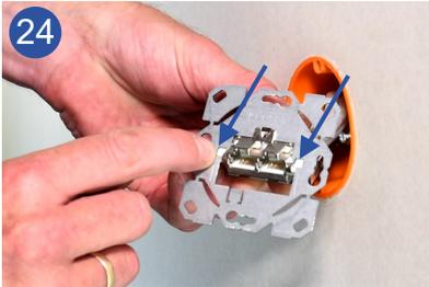
24 Verriegeln Sie die beiden seitlichen Rastnasen durch leichten Fingerdruck in den Montagerahmen.
