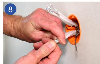
Durch Umbiegen der Aderpaare reißt die Schirmfolie auf und kann abgezogen werden.
