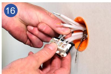
16 Achten Sie dabei auch auf die korrekte Farbzuzuordnung und die entsprechende Zuordnung zum jeweiligen Kabel. Verschließen Sie die Kontaktblöcke nacheinander durch Druck mit den Fingern. Achten Sie darauf, dass die Adern beim Verschließen nicht mehr aus dem Kontaktblock zurück gleiten.
