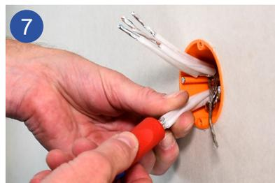
Schneiden Sie die Schirmfolien rundum mit dem geeigneten Abmantelwerkzeug ca. 1 cm vor den Schutzschläuchen ein.
