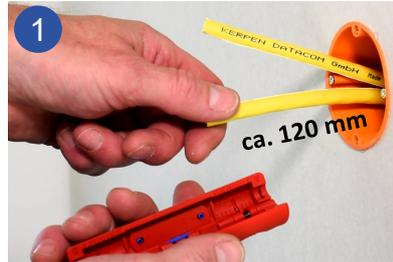
Für eine korrekte Installation der Anschlussmodule wird eine Kabellänge von jeweils ca. 120 mm benötigt. Schneiden Sie dann den Kabelmantel mit dem Abmantelwerkzeug bis tief in die Leerdose an.
