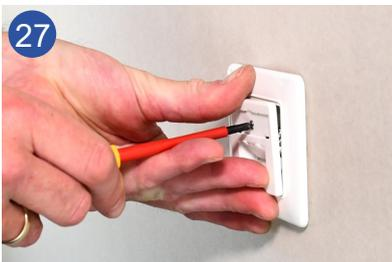
27 Montieren Sie die Zentralscheibe und den optionalen Abdeckrahmen. Benutzen Sie die Schraube in der Mitte des Beschriftungsfeldes, um die Zentralscheibe mit der Anschlussdose zu verbinden.
