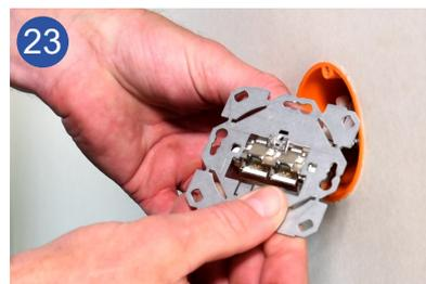
23 Setzen Sie den Montagerahmen von oben hinter die V-Führung in das Anschlussmodul ein.
