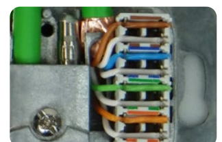
Abb.: Überstehende Adern abgeschnitten
