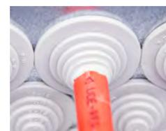
Abb. 1: Stufennippel mit Schutzart IP55 am Kabeleingang
