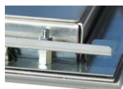
Detail Klemme, Bolzen und Federlaschenverbindung
