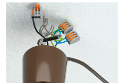
Anschluss von Leuchten mit feindrähtiger Weiterleitung
