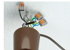
Anschluss von Leuchten mit feindrähtiger Weiterleitung
