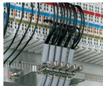
Schirmklemmbügel auf anwendungsspezifisch gefertigtem Cu-Sammelschienenbügel (10 x 3) mm
