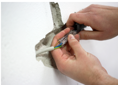
Leitung mit Leitungsreparaturset verbinden.
