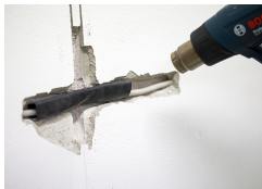
Schrumpfschlauch erhitzen und Schadstelle wieder fachgerecht verschließen.
