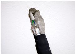
Leitung mit Leitungsreparaturset verbinden.
