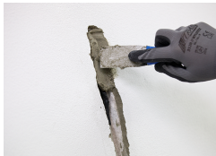
Schadstelle unsichtbar verschließen.
