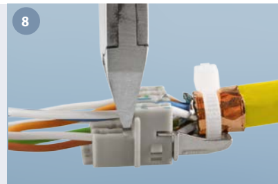
8 Adern bündig am Adersortierer abschneiden. Trim wires flush with the cable sorter.
