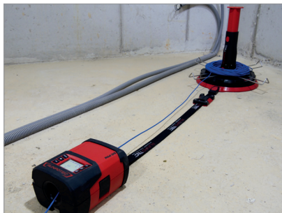
RM35 mit XB 300 und Multifunktionsdorn mit Einzelader
